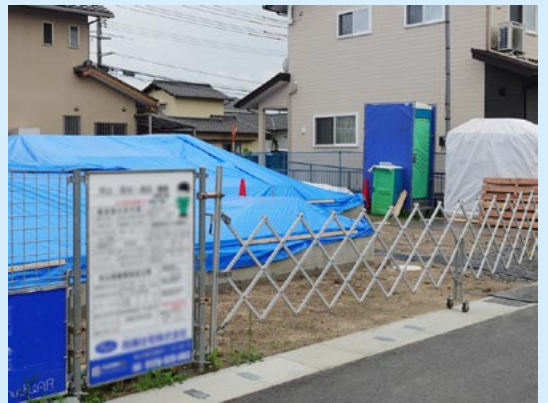
住宅建築現場 GXシリーズ P5~10 住宅建設関連商品 P31~32
